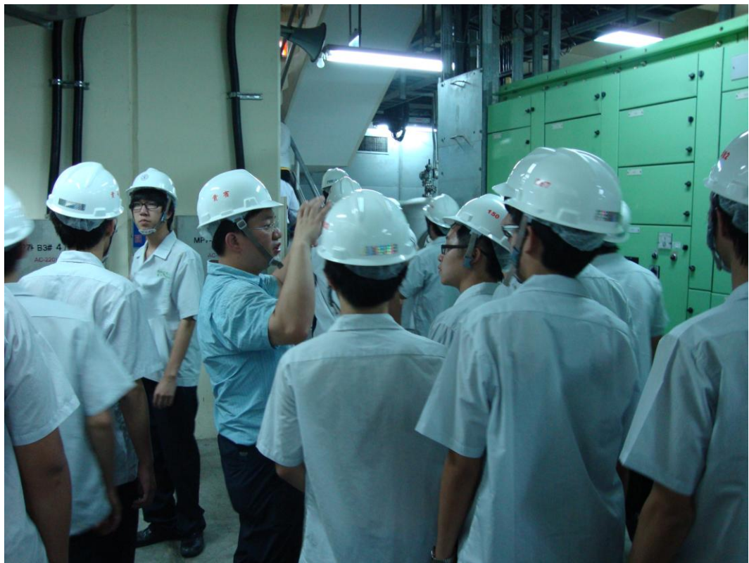
實際進入廠房參觀橫式發電機組
