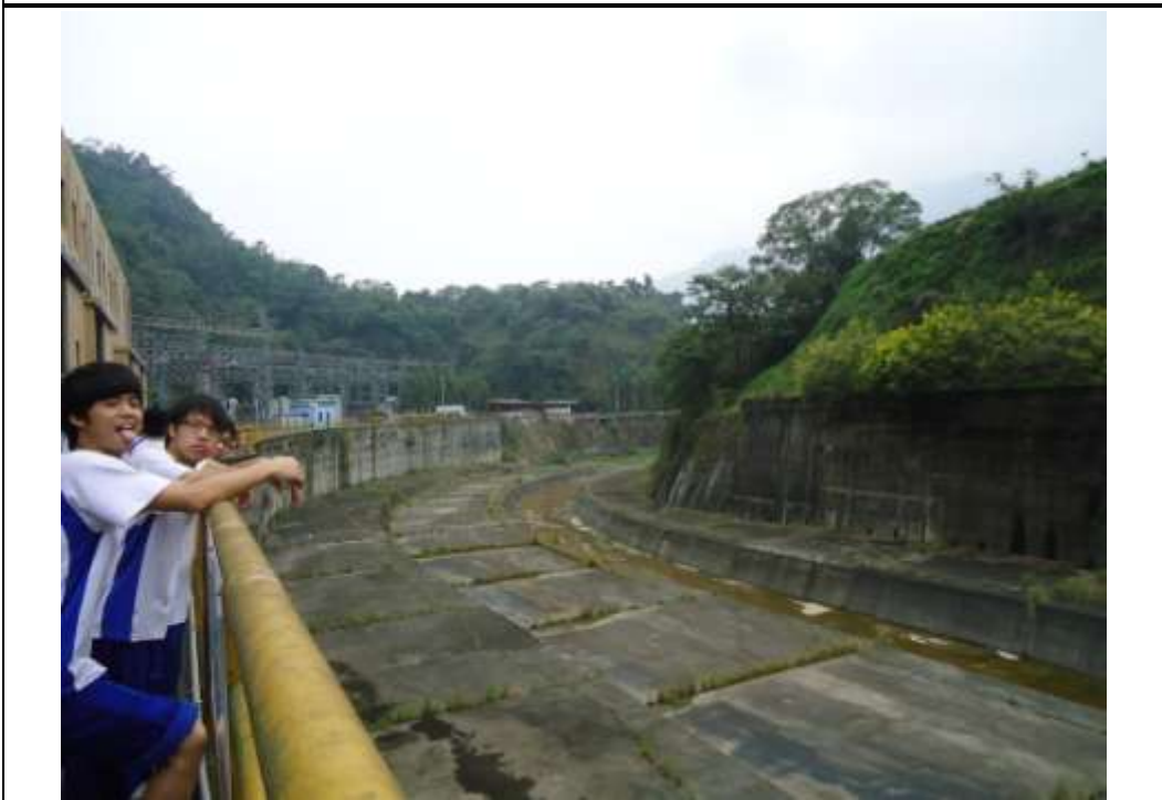
廠房外排沙道
