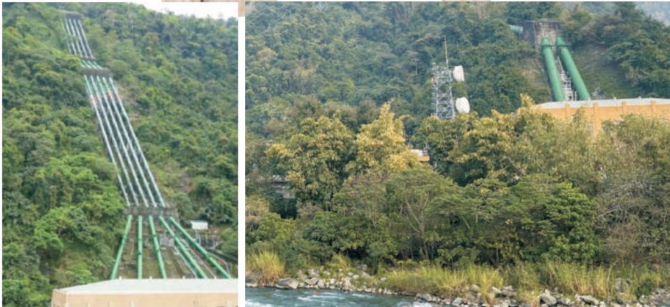
水，再由兩條壓力鋼管輸送至鉅工發電廠發電。有更驚人的數據顯示：兩部豎軸法蘭西斯式水輪發電機，每部21.75MW，總裝置容量為4.35萬瓩（43.5MW），年發電量約為1.5億度。
