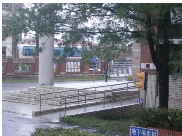
正門無障礙坡道
