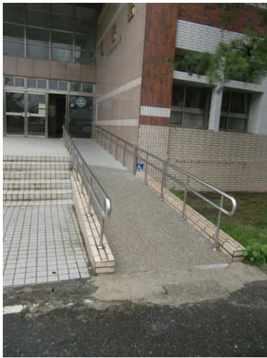
正門無障礙坡道
