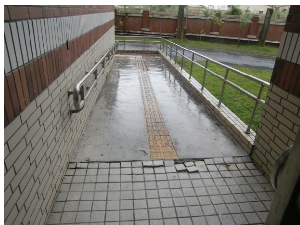
側門無障礙坡道
