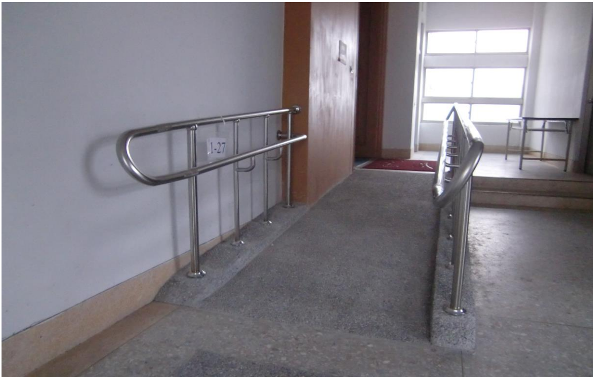
四樓國際會議廳之殘障坡道
