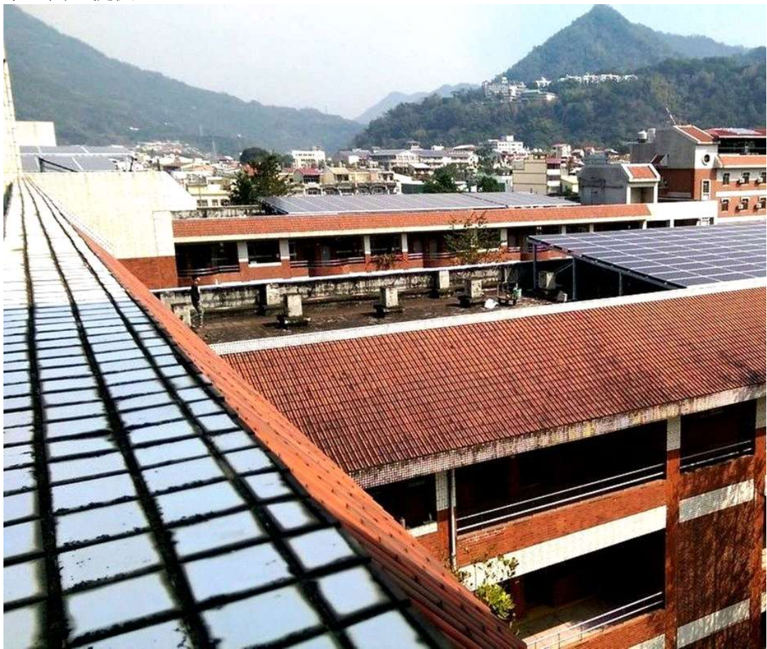
水里商工屋頂裝太陽能光電板，一舉三得解決漏水、隔熱及發電的收入。圖／水里商工提供
