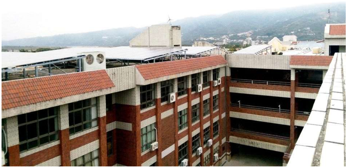
水里商工屋頂裝太陽能光電板，一舉三得解決漏水、隔熱及發電的收入。圖／水里商工提供
