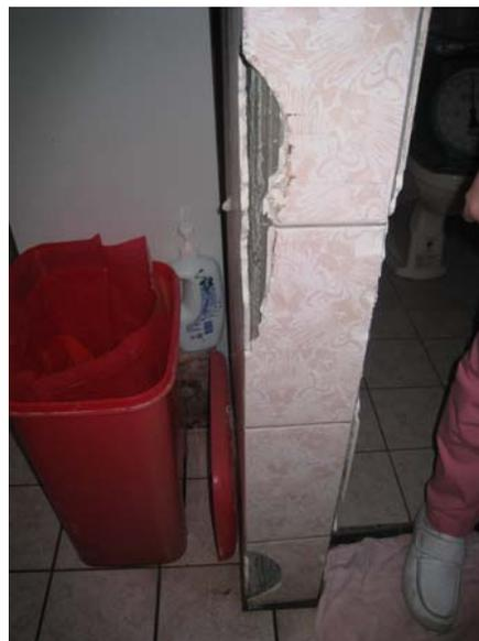
推床撞裂的瓷磚可能造成割傷
