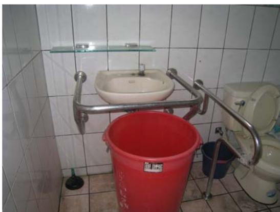
不堪使用的洗面盆（由於洗臉盆破裂以桶子接水
