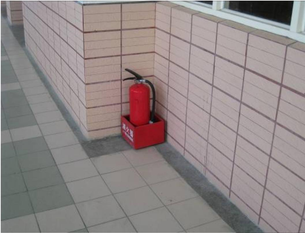
將滅火器放置於角落，雖可避免撞及，惟因走道邊緣不平整（有柱子突出），影響視障者行進，並非良好作法
